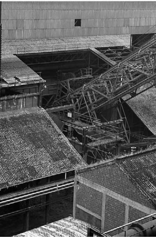
Amorce du plan incliné (partie supérieure - raillage du chariot contrepoids) et molette de renvoi du câble de contrepoids. Vue depuis l'intérieur du hall de préparation des charges.
