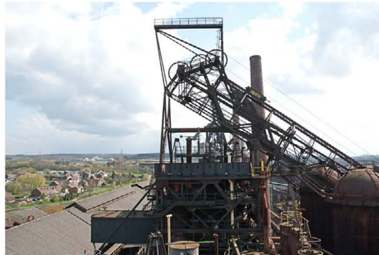
Vue sur la grue du monte-charge au sommet du haut fourneau. Lorsque la benne arrivait au niveau du gueulard, le raillage inférieur du plan incliné présentait une déviation permettant à cette benne de se présenter sur un socle. En même temps, elle chassait le bouchon du sas du gueulard et un dispositif provoquait l'ouverture du clapet inférieur de la benne afin de libérer la charge. A noter également la présence de trois molettes de guidage du câble de traction.
